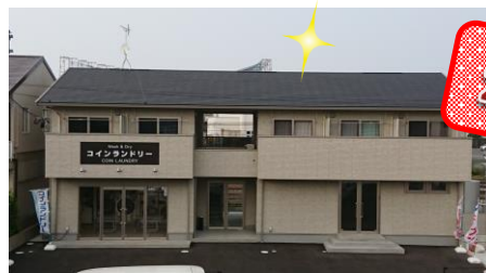
令和元年6月 2号館完成
